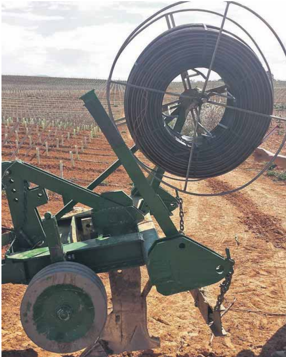
Máquina de instalación de goteo subterráneo.
